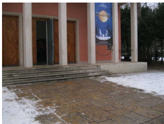
Weg über Stufen zum Haupteingang
