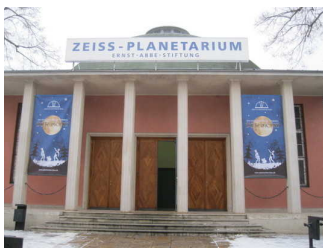
Treppe zu Haupteingang
