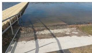
Zugang zum Wasser über Treppe oder Rampe
