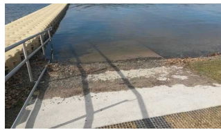
Zugang zum Wasser über Treppe oder Rampe
