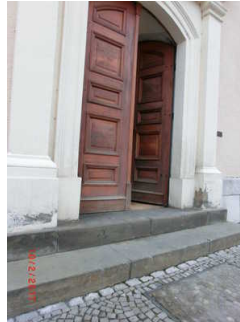
Tür mit Rufanlage für Servicepersonal
