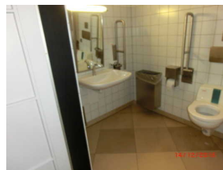
WC und Waschbecken
