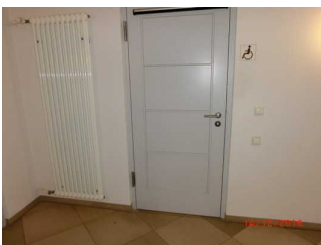
Vorraum und Tür zum WC
