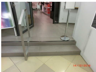
Treppenstufen zum Shop
