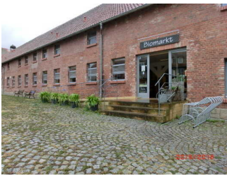
Hofladen mit Treppe und Rampe
